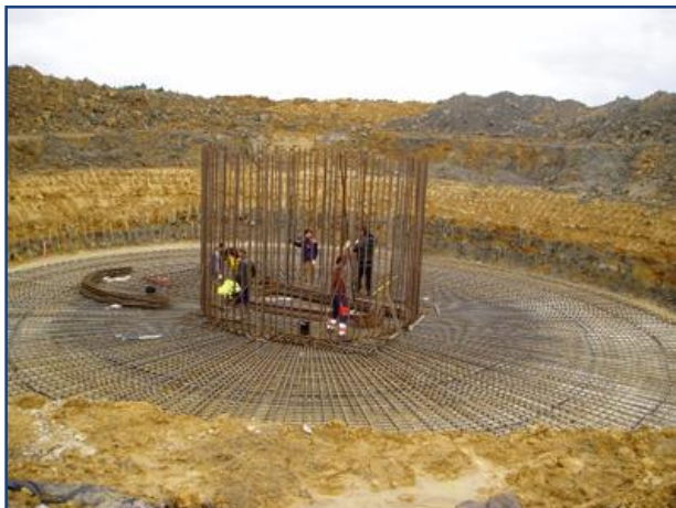
Opération de ferrailage en septembre 2010
