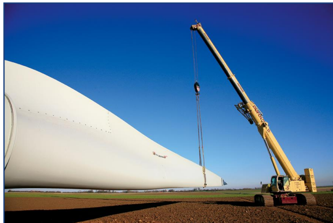
Levage d'une pale d'une éolienne en février 2011
