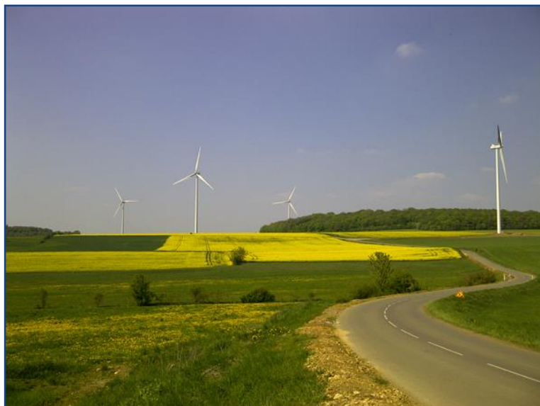
Parc éolien des 2 Rivières
