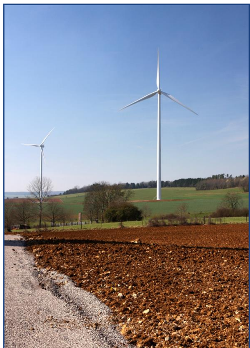
Parc éolien des 2 Rivières
